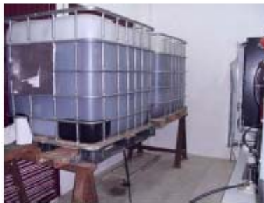
Depósitos nodriza de combustible
