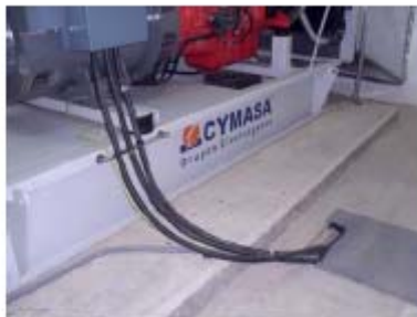
Nueva acometida de conexión del motogenerador y la soplante 2
