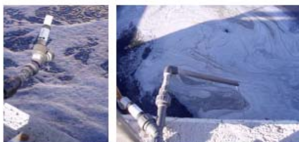
Puntos de dosificación de reactivos
